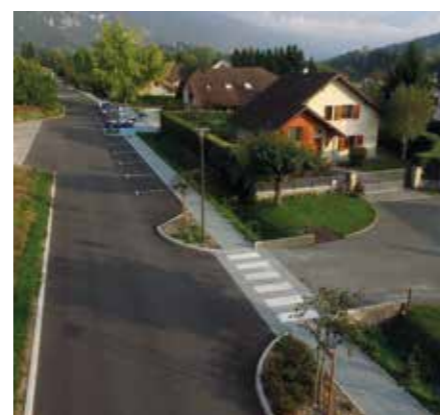
LA ROUTE DU BIEF DU MOULIN APRÈS LES TRAVAUX.
