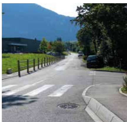
LA ROUTE DU BIEF DU MOULIN AVANT LES TRAVAUX.
